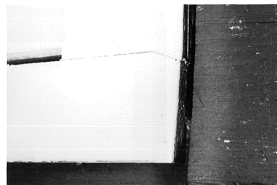
Figur 59. Den ny klima-simulator: Hjørnesamling af vindue efter 2½ måneds ældning.
