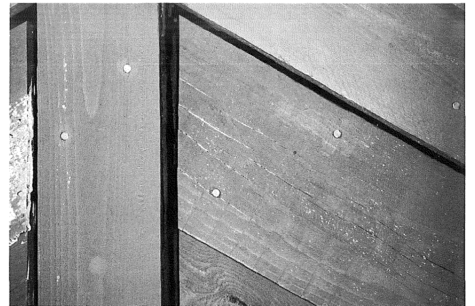
Figur 24. "De fire årstider": Spidsafslutning af brædde- beklædning efter 2½ må- neds ældning.
