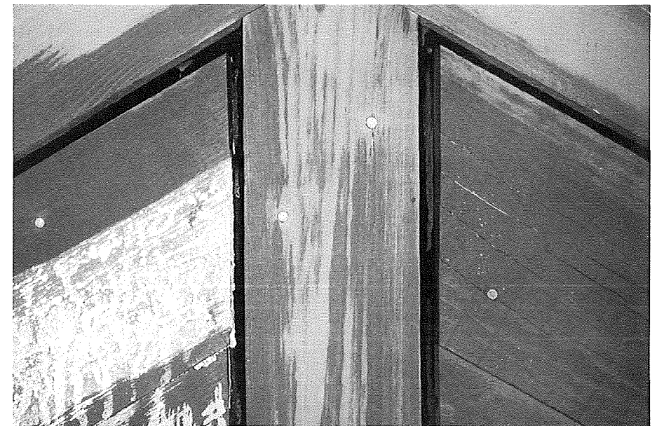
Figur 25. "De fire årstider": Spidsafslutning af brædde- beklædning efter 5½ må- neds ældning.
